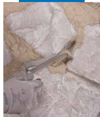
Výplň spár v kamenném zdivu
