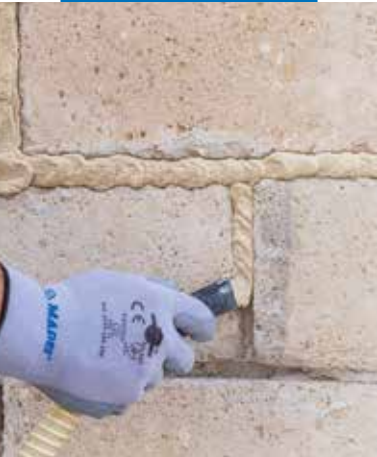
Aplikace Mape-Antique Allettamento
