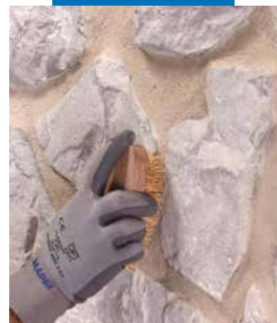
Konečná úprava povrchu kartáčem
