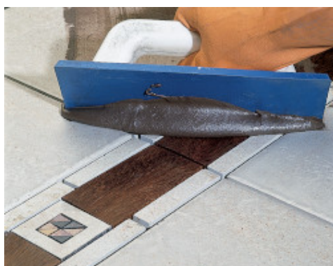
Spárování keramické dlažby s vloženými dřevěnými prvky stěrkou
