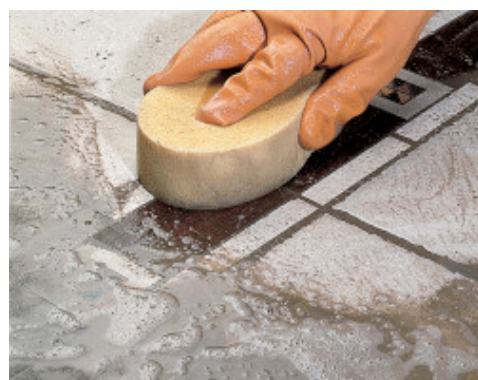
Dočištění keramické dlažby s vloženými dřevěnými prvky houbou
