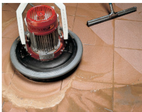
Konečná úprava dlažby gres elektrickým spárovacím a čisticím strojem a stěrkou
