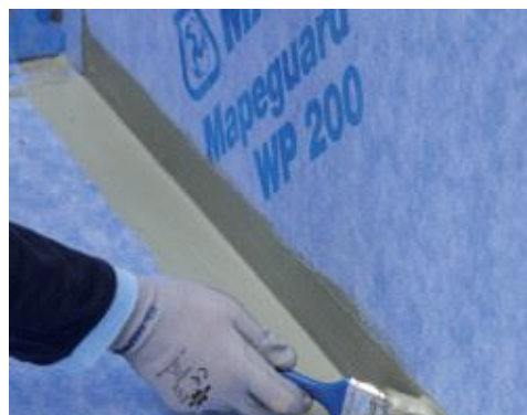
Aplikace lepidla Mapeguard WP Adhesive před lepením pásky Mapeguard ST k utěsnění rohu
