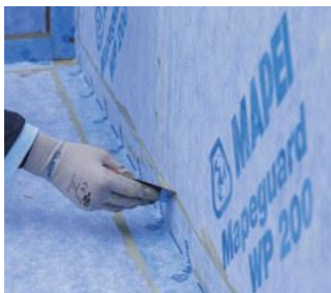
Aplikace těsnicí pásky Mapeguard ST
