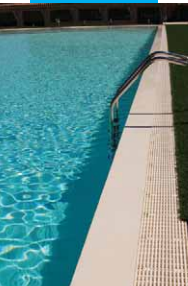
Pohled na bazén s povrchovou úpravou Elastocolor Waterproof
