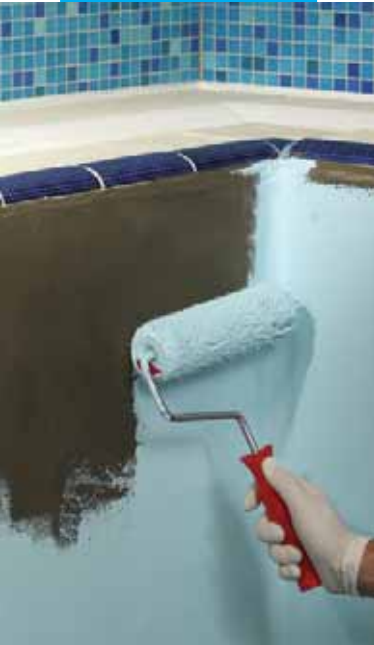
Aplikace Elastocoloru Waterproof válečkem
