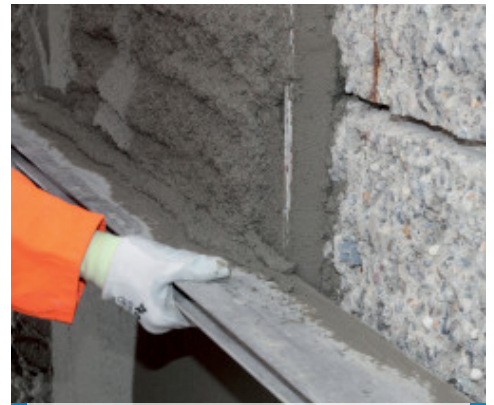
Stahování malty Mapegroutu 430 srovnávací latí
