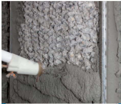
Strojní aplikace malty Mapegrout 430
