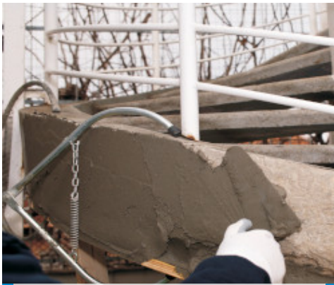
Aplikace malty Mapegrout 430 zednickou lžící
