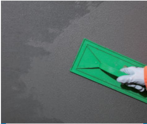
Konečná úprava malty Mapegrout 430
