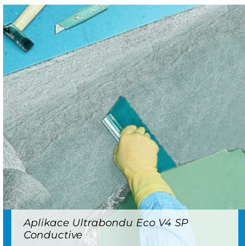
Pokládka vodivých PVC dílců spoužitím Ultrabondu Eco V4 SP Conductive
