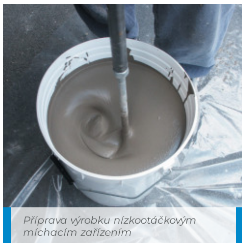
Příprava Ultratopu v míchačce
