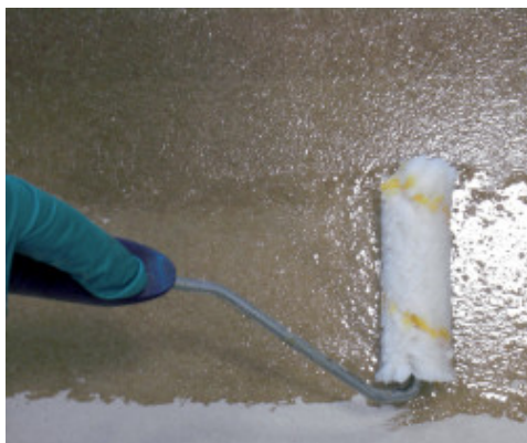
"Benátský efekt" - aplikace Mapeflooru I 910
