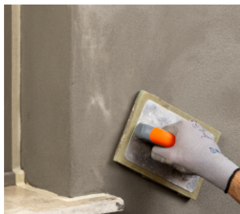
Konečná úprava Planitopu 210 Zero
