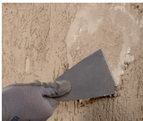
Odstranění všech nesoudržných povrchových úprav
