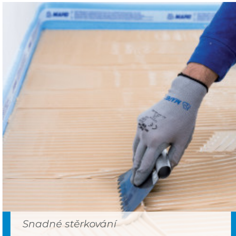
Částečné odstranění uzavírací fólie pro prodloužení doby zpracovatelnosti
