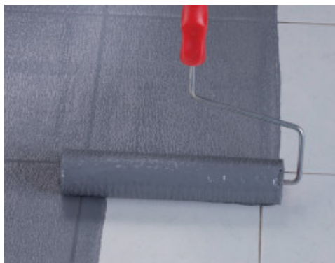
Aplikace Eco Primu Grip válečkem na stávající keramickou dlažbu typu gres
