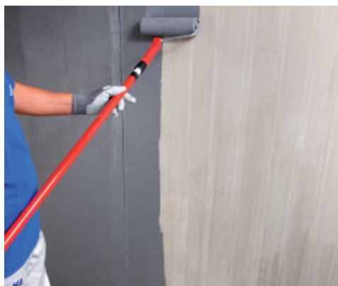
Aplikace Eco Primu Grip Plus válečkem na betonový podklad
