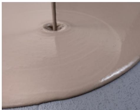
Aplikace samonivelační stěrky na vyschlý Eco Prim Grip Plus aplikovaný na staré podlaze
