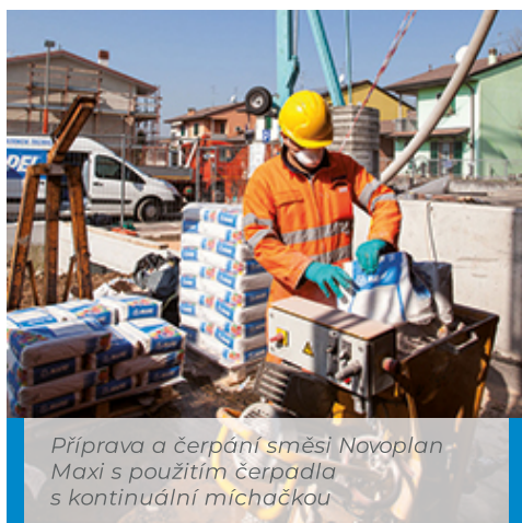
Čerpání a vyrovnání povrchu Novoplan Maxi
