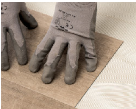
Instalace LVT s použitím Ultrabond Eco V4 Evolution ZERO
