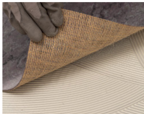
Instalace linolea s použitím Ultrabond Eco V4 Evolution ZERO
