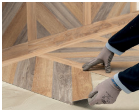
Instalace MODULÁRNÍHO LVT s použitím Ultrabond Eco V4 Evolution ZERO
