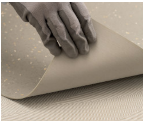
Instalace GUMY s použitím Ultrabond Eco V4 Evolution ZERO
