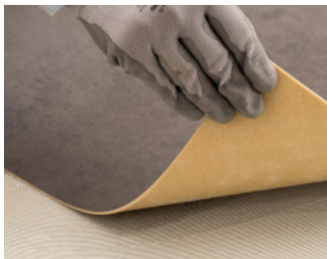
Instalace polyuretanové krytiny s použitím Ultrabond Eco V4 Evolution ZERO
