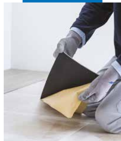
Odstraňování ochranné fólie ze samolepicích LVT dílců
