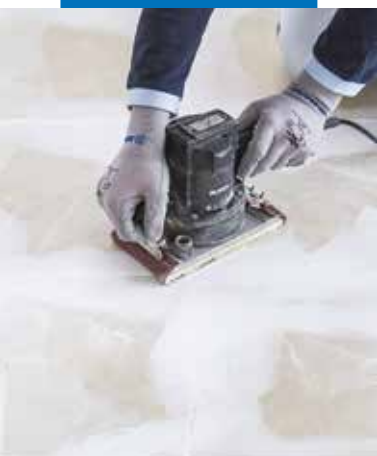
Broušení povrchu vyrovnaného s použitím výrobku Planiprep 4 LVT
