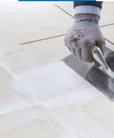
Vyrovňávání a uzavření spár stávající keramické dlažby s použitím výrobku Planiprep 4 LVT
