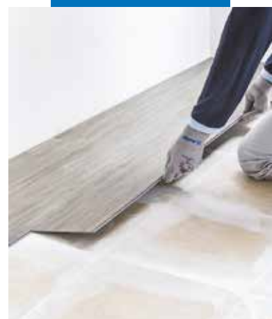
Pokládka LVT s Click systémem na povrch keramické dlažby vyrovnaný s použitím výrobku Planiprep 4 LVT
