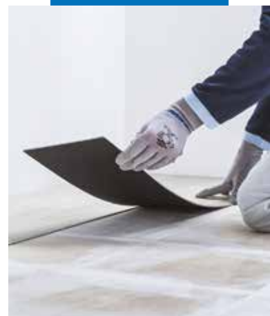
Pokládka samolepicích LVT dílců na povrch keramické dlažby vyrovnaný s použitím výrobku Planiprep 4 LVT
