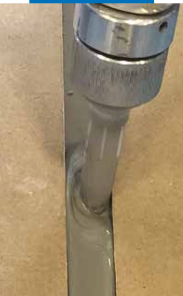
Aplikace čerpadlem Mapeflex SPP
