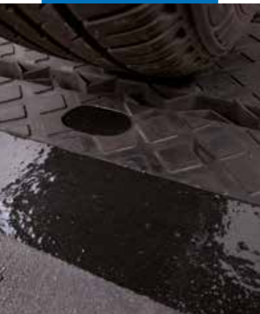
Polymerizovaný Mapeflex PU 65 připravený na pojezd
