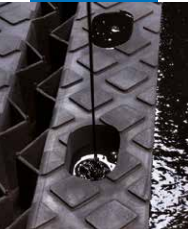
Lití Mapeflexu PU 65 při kotvení
