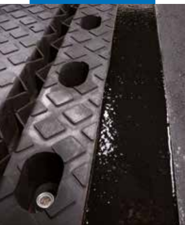
Přechod těsnění s použitím Mapeflexu PU 65 smíchaného s pískem
