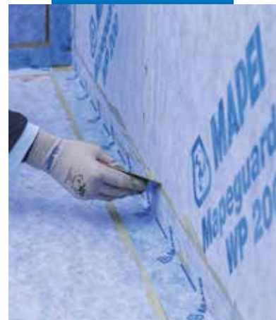
Aplikace těsnicí pásky Mapeguard ST
