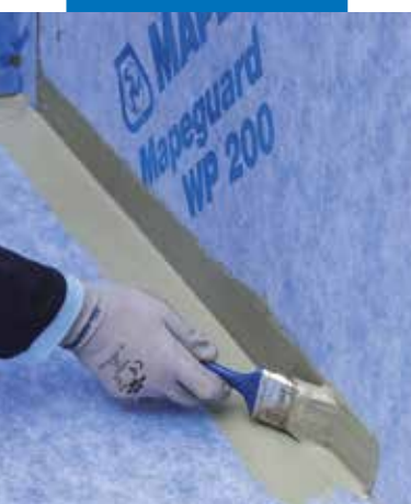
Aplikace lepidla Mapeguard WP Adhesive před lepením pásky Mapeguard ST k utěsnění rohu
