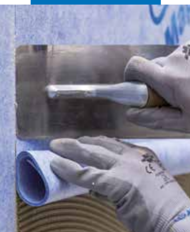
Instalace druhého pásu
