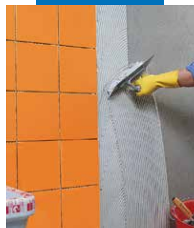
Lepení keramického obkladu na MapeWall Intonaca & Rinforza
