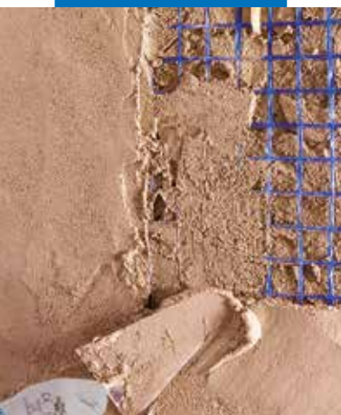
Aplikace druhé vrstvy MapeWall Intonaca & Rinforza
