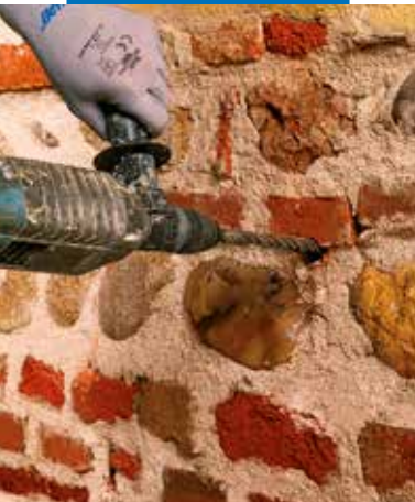
Vrtání otvorů pro MapeNet EM Connector
