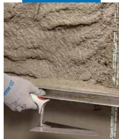
Vyrovňávání malty MapeWall Intonaca & Rinforza stahovací latí
